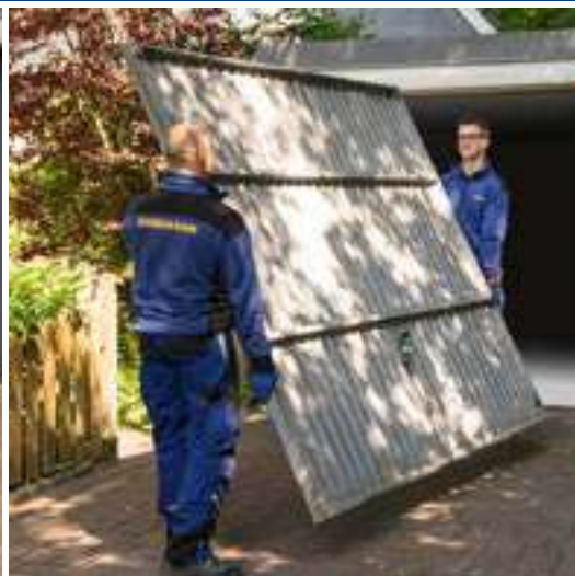
Ausbau und umweltgerechte Entsorgung
