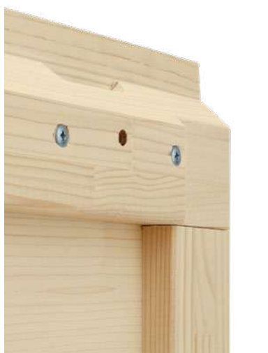
Verstärkung an den Lamellenenden
